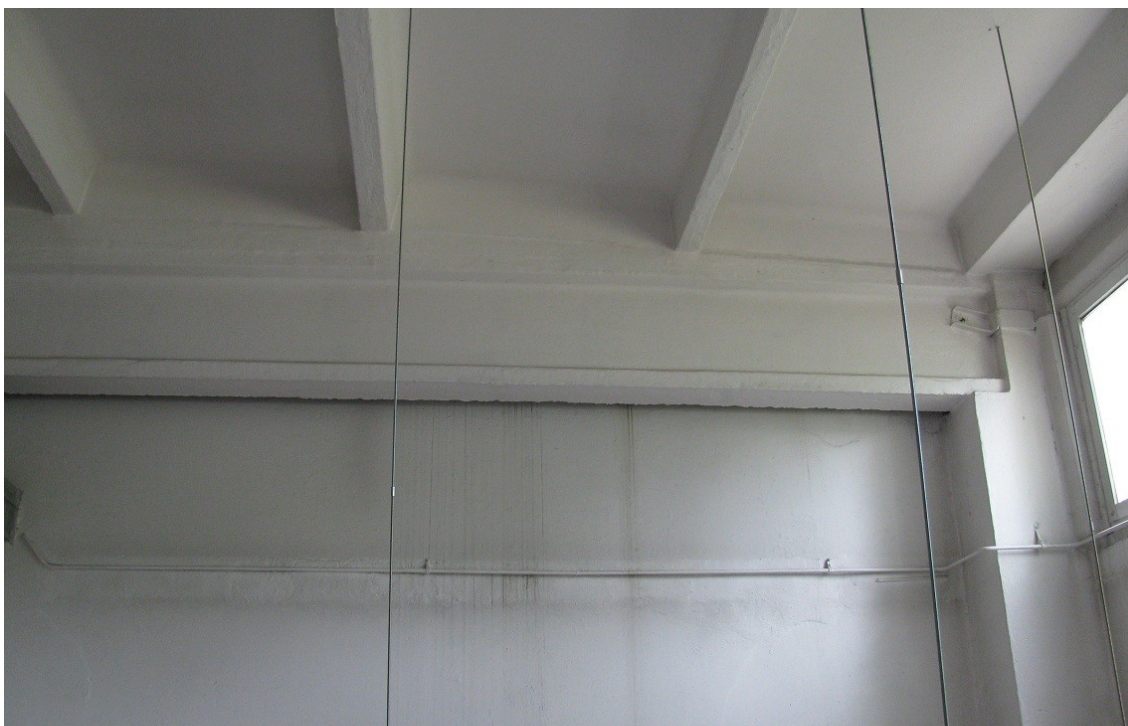
Ilustracja 9: Słup, dźwigar, płyty dachowe budynku stołówki
