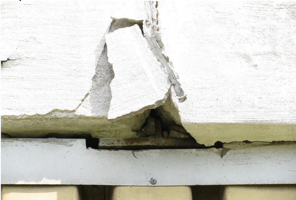
Ilustracja 10: Wspornik teowy płyty elewacyjnej
